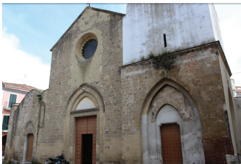
Fig. 6. Prospetto della chiesa di Santa Maria a Piazza.
