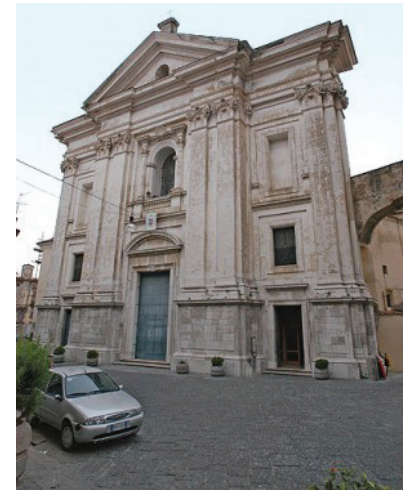
Fig. 8, a. Facciata della cattedrale di San Paolo.
